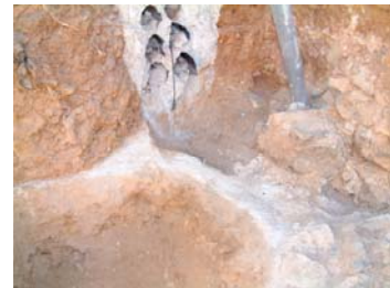
Detalls del nivell de morter de calç que aparegué per sobre i darrera de la última volta del viaducte. En les imatges s'aprecia clarament com el morter continua cap a l'interior del tall de l'excavació, així com el forat que féu la màquina en extreure les terres que cobrien les voltes.
