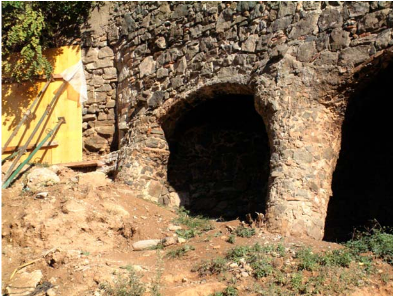
La imatge mostra el punt de connexió de l'antiga muralla medieval i el viaducte gaudinià
