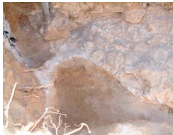
Detalls del nivell de morter de calç que aparegué per sobre i darrera de la última volta del viaducte. En les imatges s'aprecia clarament com el morter continua cap a l'interior del tall de l'excavació, així com el forat que féu la màquina en extreure les terres que cobrien les voltes.
