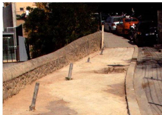
Vista del Sector 1 una vegada s'havia aixecat el panot de la vorera
