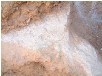
Detalls del nivell de morter de calç que aparegué per sobre i darrera de la última volta del viaducte. En les imatges s'aprecia clarament com el morter continua cap a l'interior del tall de l'excavació, així com el forat que féu la màquina en extreure les terres que cobrien les voltes.
